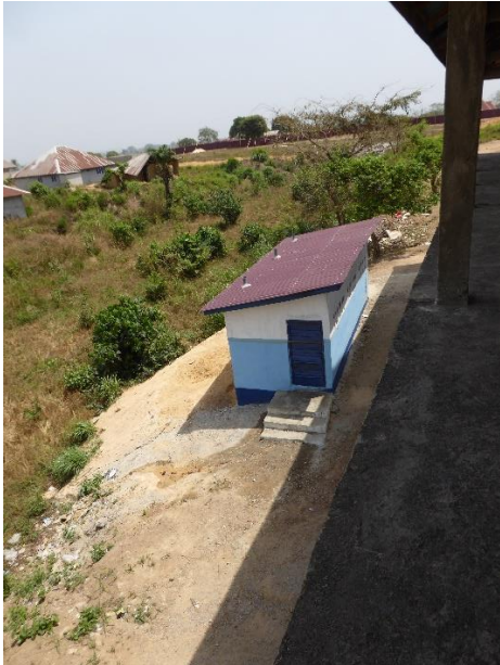
Das neue Toilettengebäude der Schule (Stand 02/ 2024)
